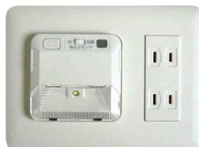
停電と同時に点灯する 「足元保安灯」
